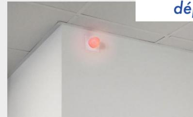
La verrine lumineuse est connectée au robot (via boîtier spécifique) et installée dans votre établissement. Elle permet d'afficher des couleurs en fonction de l'état du robot mobile (arrivé à destination, en erreur, ...) afin d'avertir visuellement les utilisateurs.
